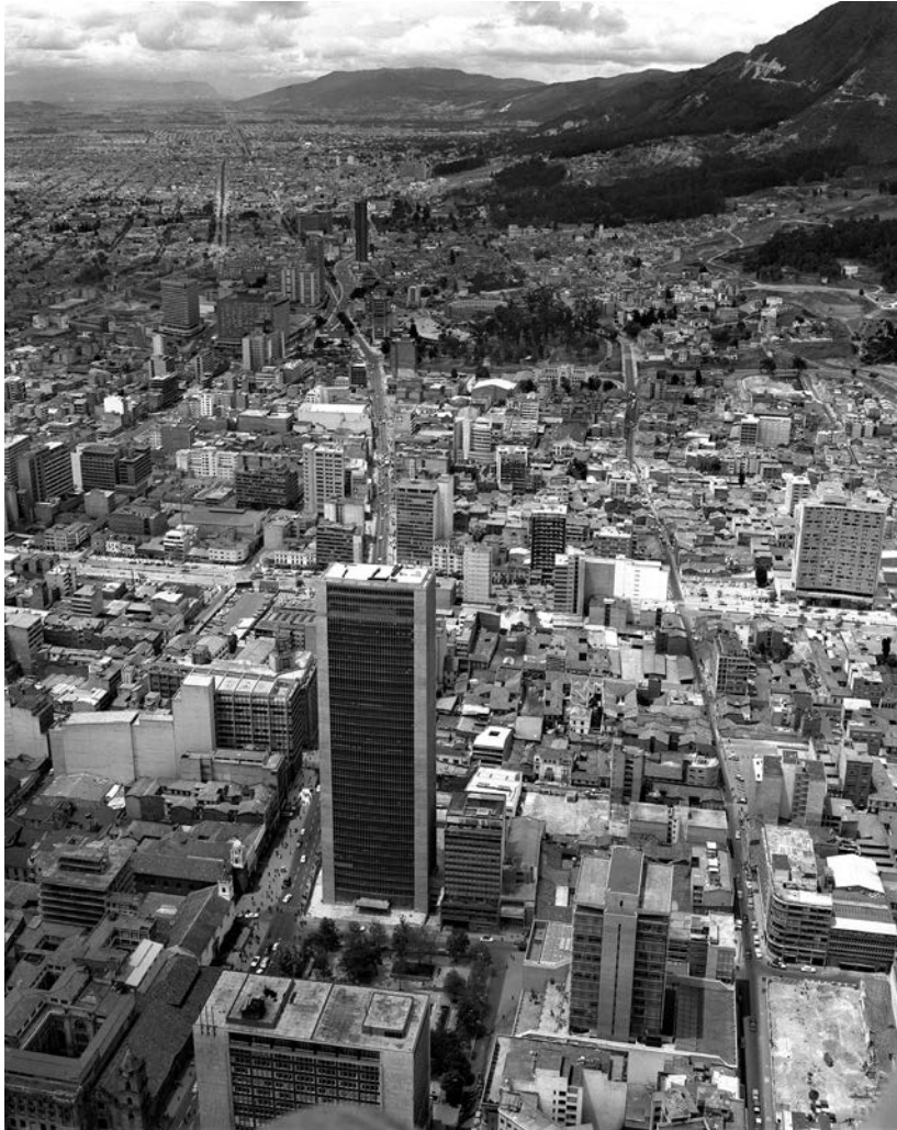
Rudolf. Edificio Avianca, 1969. Panorámica hacia el norte. Rudolf. Fuente: Archivo Histórico Foto Rudolf DVD57A
